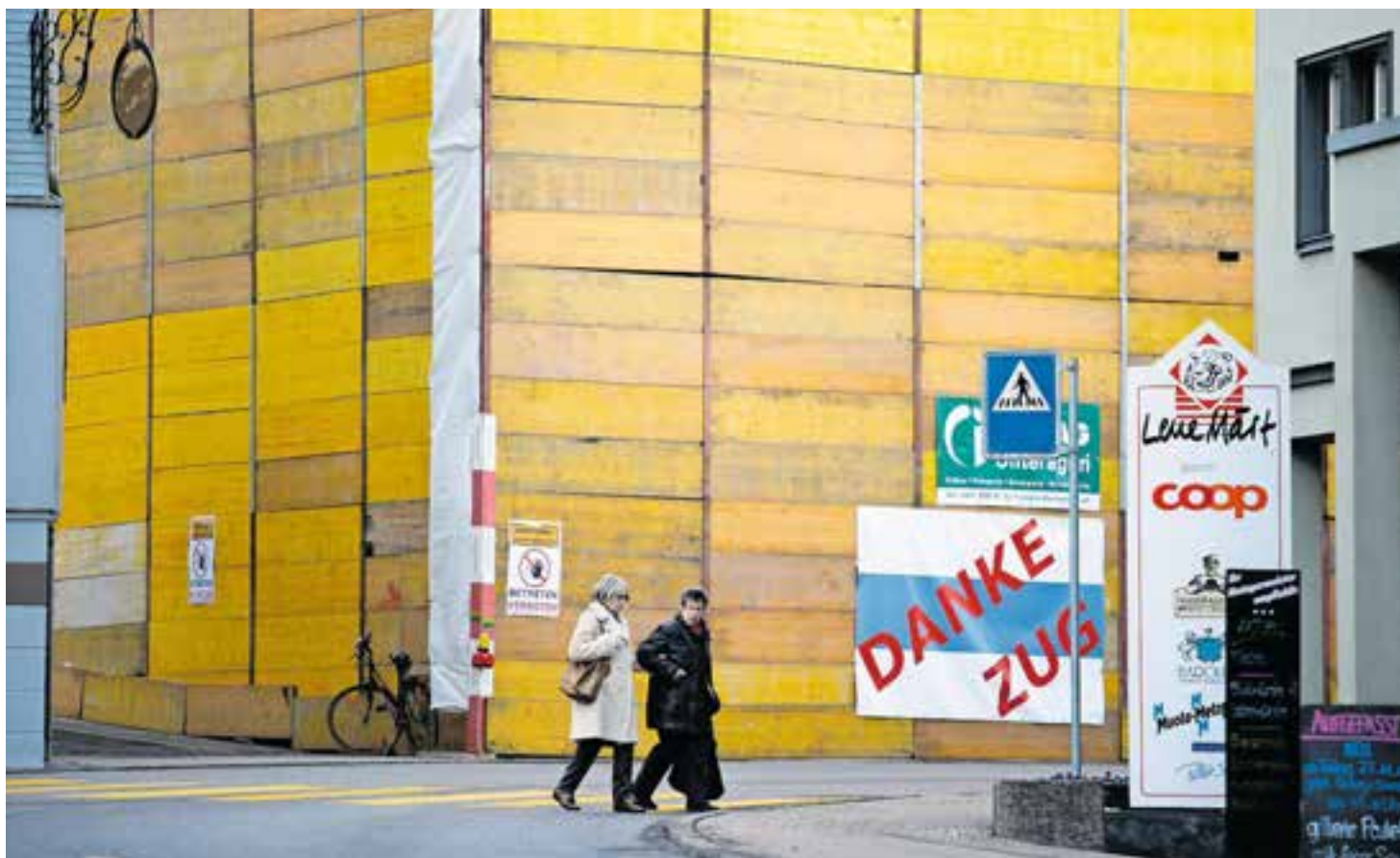
Um das Haus an der Hauptstrasse 4 in Oberägeri tobte ein langer Rechtsstreit. Der Slogan «Danke Zug» ist eine Anspielung auf die Uneinigkeiten der Eigentümerschaft mit der Denkmalpflege und dem Zuger Heimatschutz.
